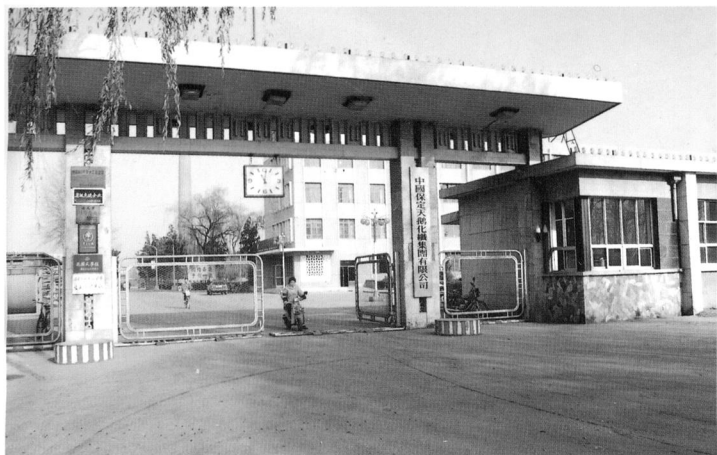
一九五八年兴建的全市大型骨干企业、八大厂之一的保定化纤厂
