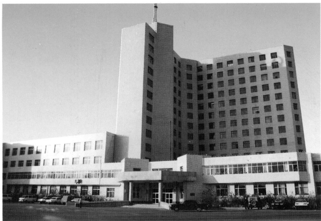
中共保定市委办公楼(建成于 1990 年)
